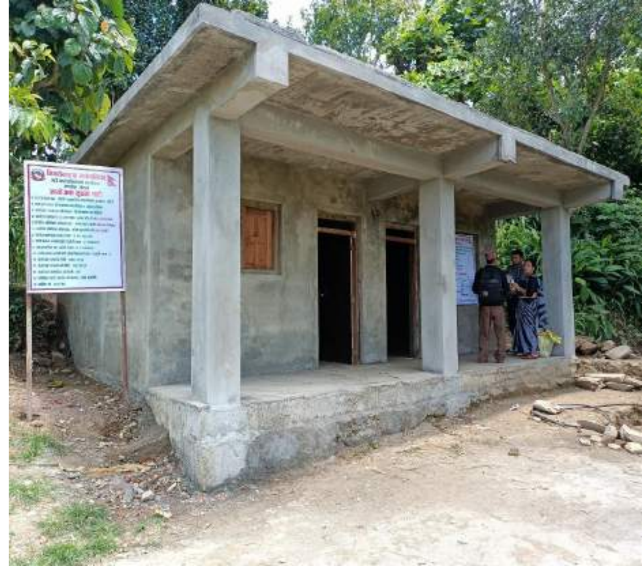
ओखले सामुदायिक भवन निर्माण, वडा २
