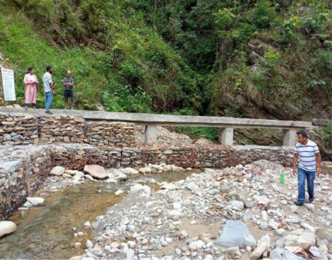
काशिखोला नैविसे खेत कुलो निर्माण, वडा ६
