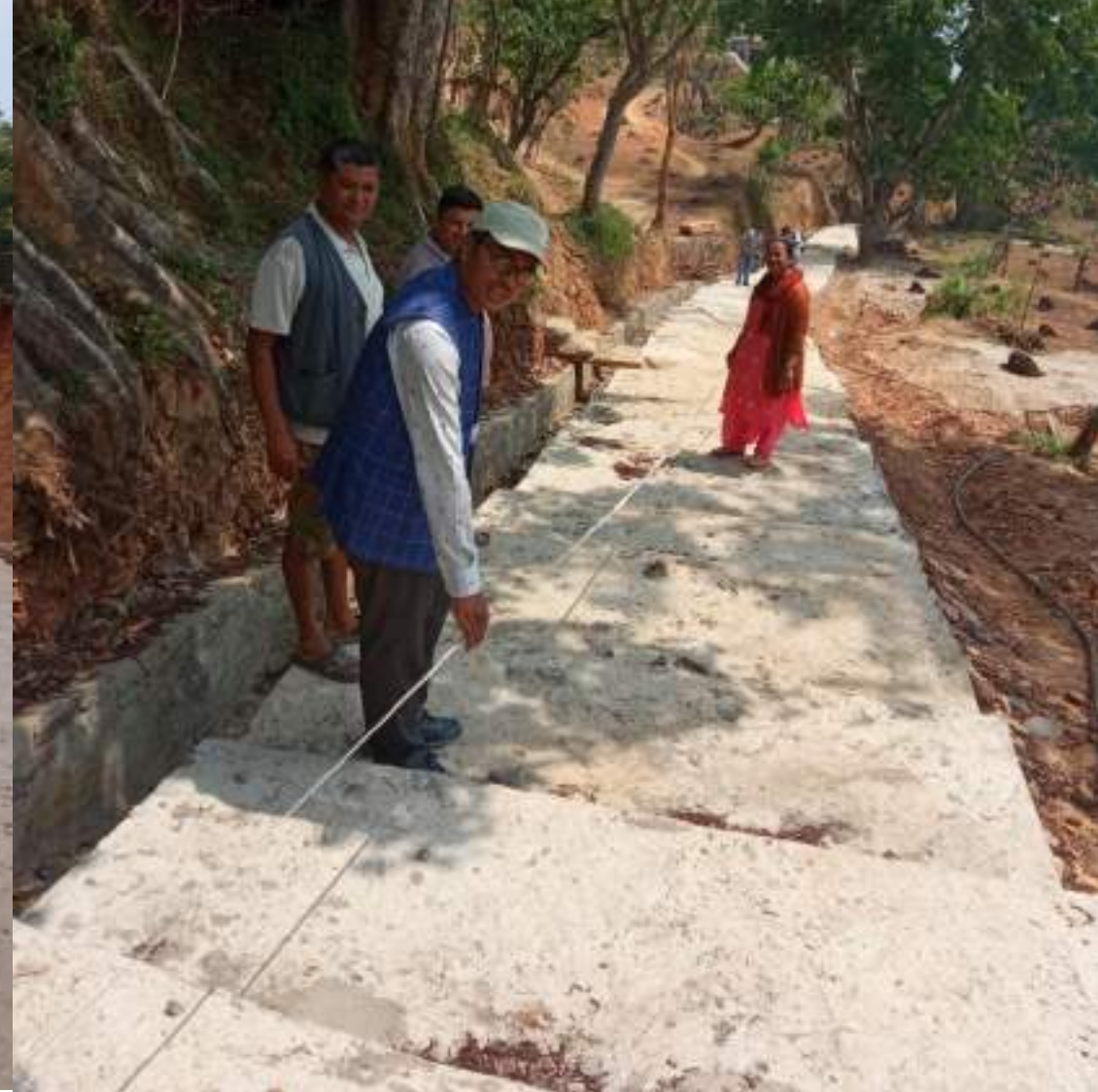
भिमसेनथापा पदमार्ग निर्माण
