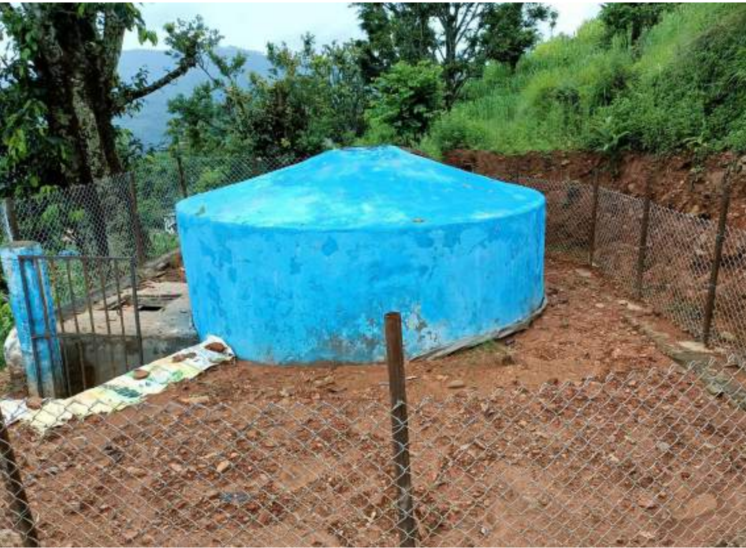
खनायोबोटे दलितबस्ती खानेपानी निर्माण, वडा ४
