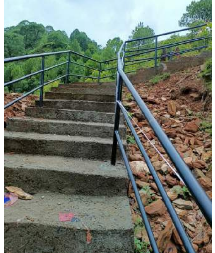
सिउडीबार सिद्धकाली मन्दिर जाने सिढीबाटो निर्माण, वडा ४
