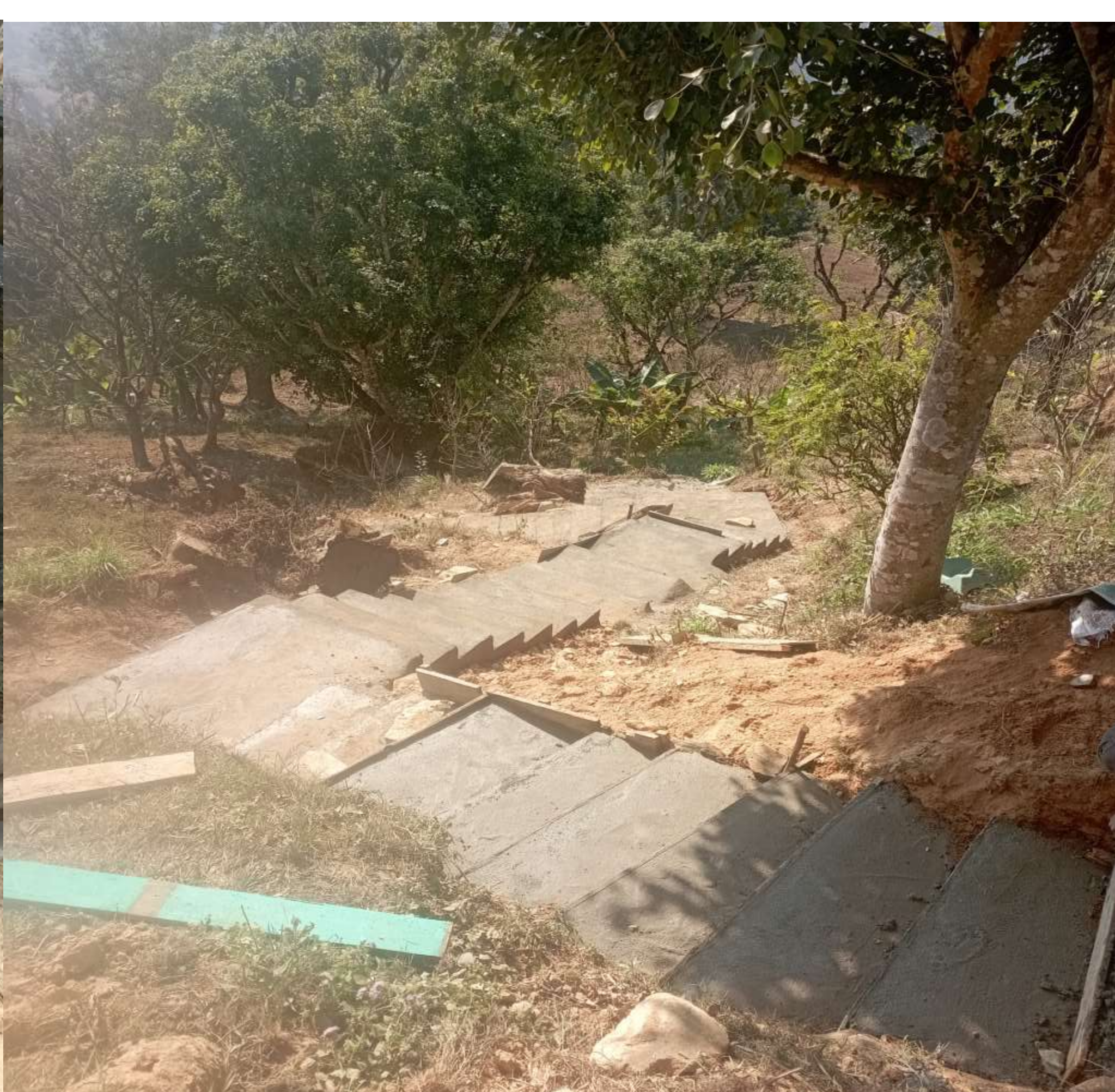
बिलेटार सिढी निर्माण
